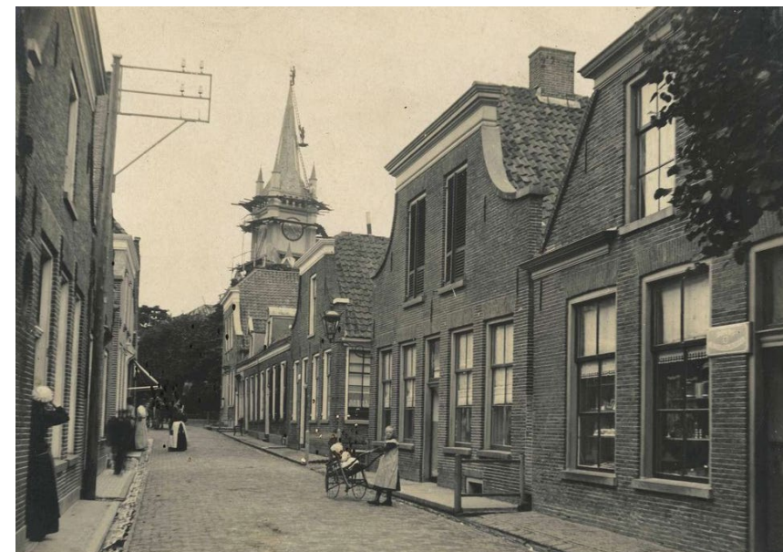
Figuur 7: Brugstaat met een Hollandse stoep voor de gebouwen, als overgang tussen de private binnenruimte en de straat (ca. 1911)
